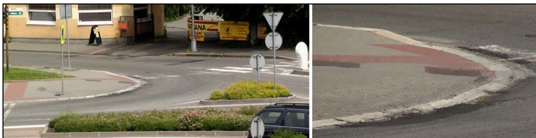
Figure 6: Damage of the curb of the by-pass on the roundabout Vsetínská – Sokolská – Žerotínova in Valašské Meziříčí
