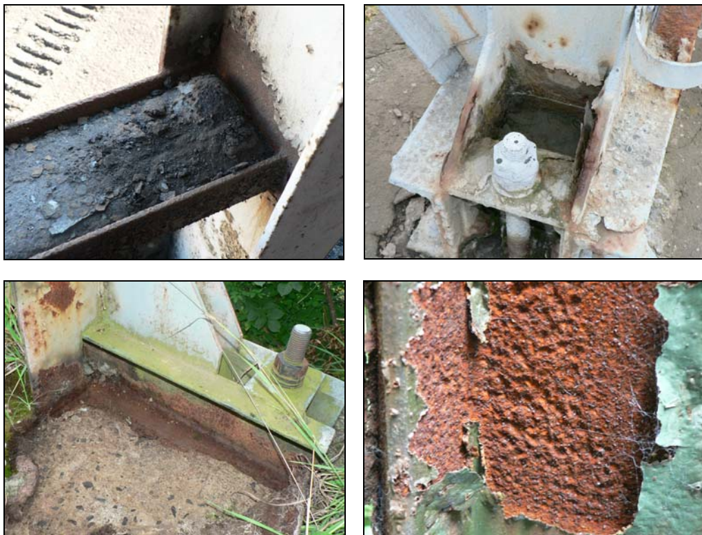
Obr. 1: Vlevo nahoře: nevhodný detail (dochází ke kumulaci sypkého materiálu); Vpravo nahoře: nevhodný detail (dochází k zadržování vody); Vlevo dole: zanedbaná údržba uložení sloupů (znečištěný základ); Vpravo dole: zanedbaná obnova protikorozní ochrany (důlková koroze).
