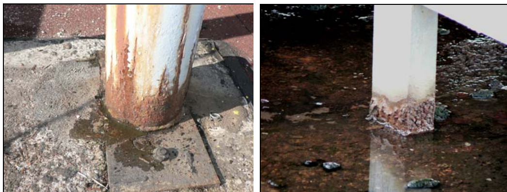
Obr. 6: Ilustrační příklady koroze spodních částí nosných sloupů.
