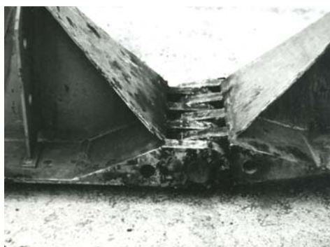
Obr. 4: Čepový styk.
