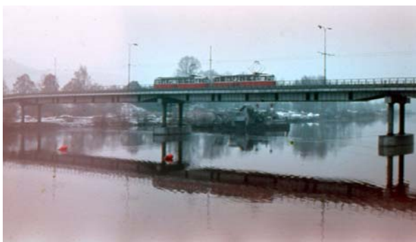
Obr. 2: Tramvajové mostní provizorium Partyzánská – Trojská přes Vltavu.
