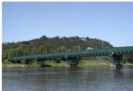
Obr. 13 Současné příhradové mostní provizorium.
