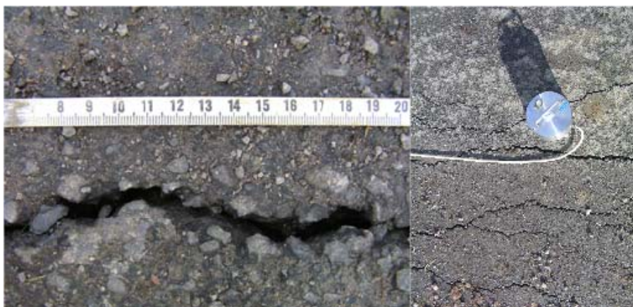
Obr. 5: Radiální trhliny na přilehlém okraji vozovky.
