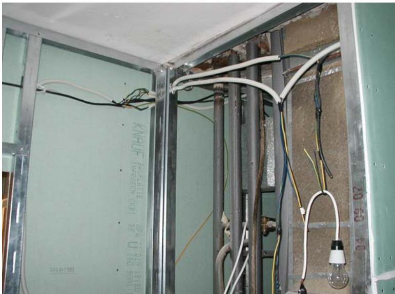
Obr.4 Vedení instalací v sádkartonových příčkách
