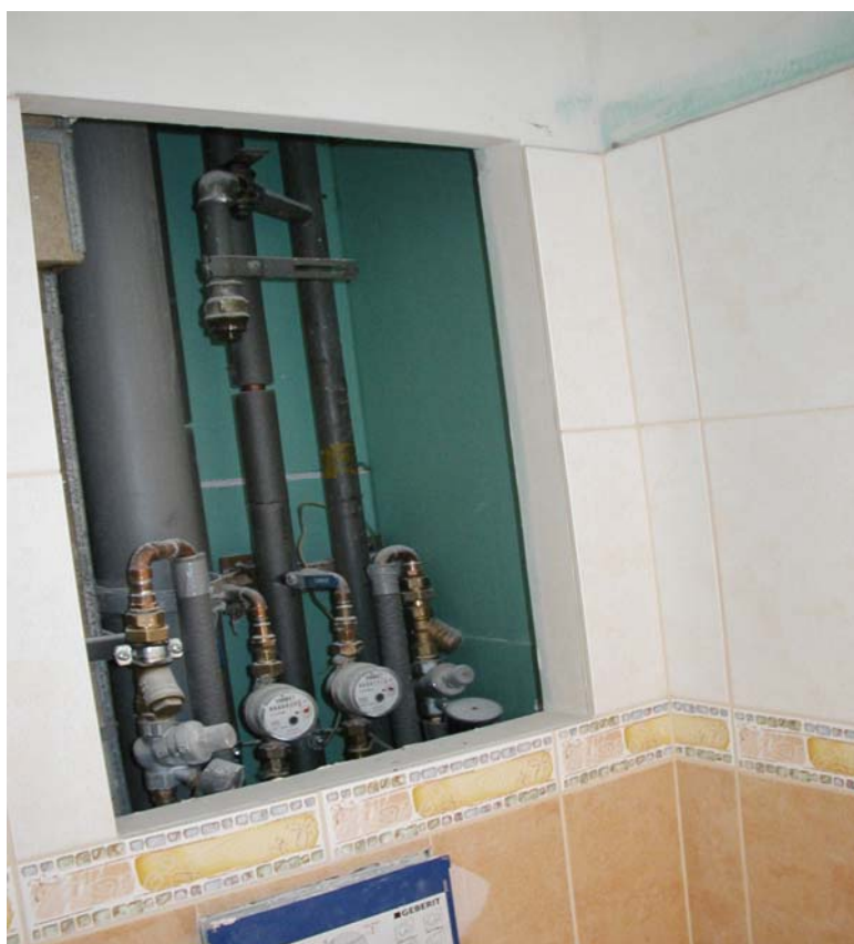
Obr.5 Umístění uzavíracích armatur a poměrových měřidel
