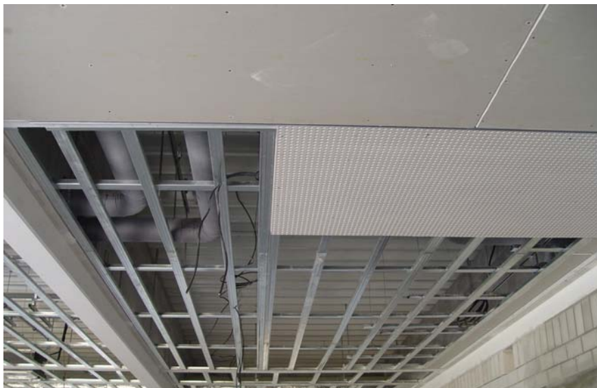
Obr.6 Příklad vedení objemných rozvodů
