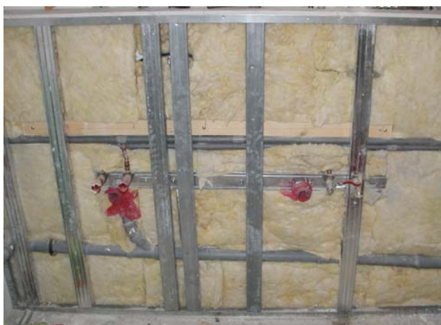
Obr.3 Příprava instalace umyvadel do sádrokartonové příčky
