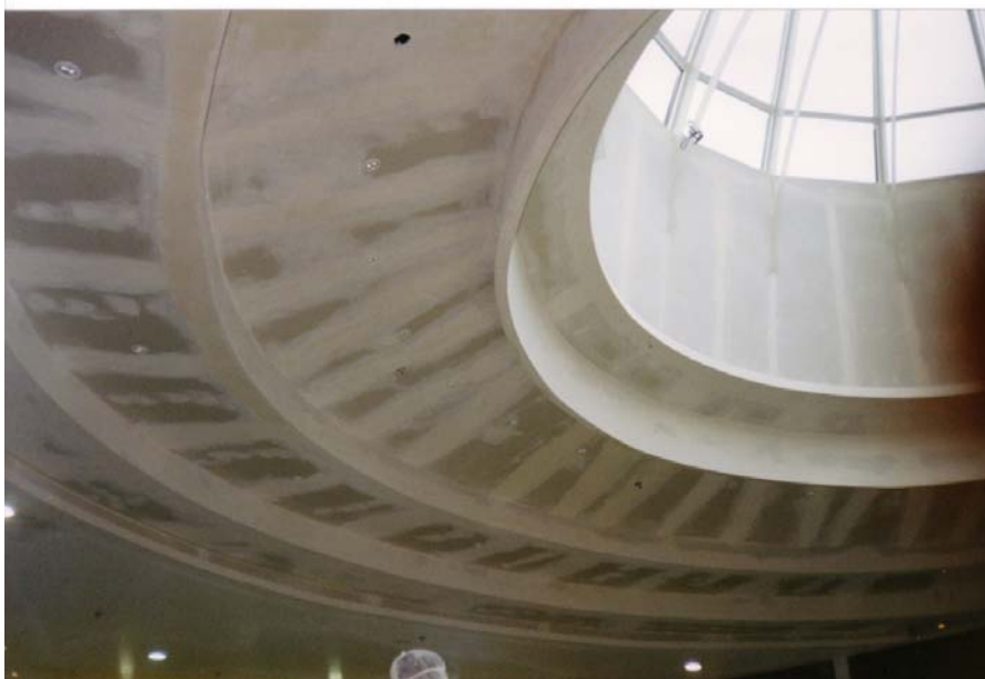
Obr.8 Sádrokartonový podhled
