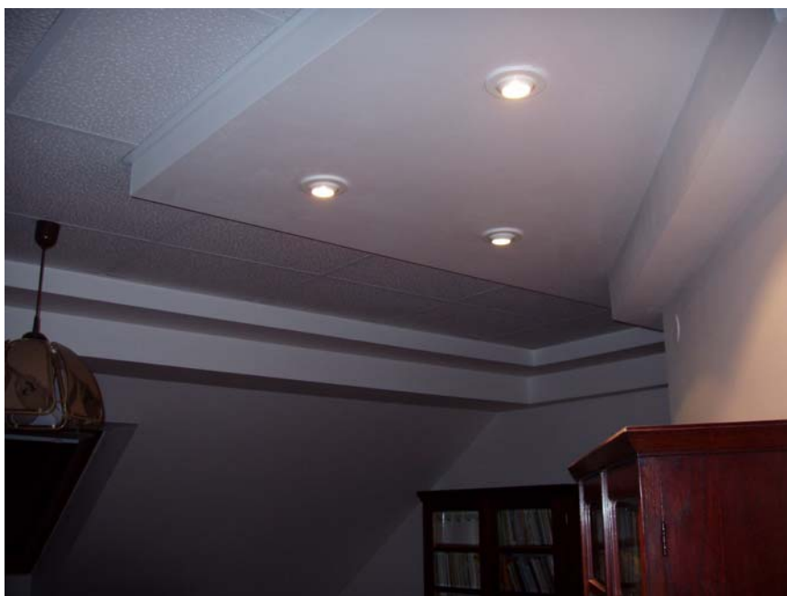
Obr.7 Sádkartonový podhled s bodovým osvětlením skryje kabelové rozvody i “trafo”
