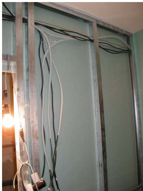
Obr.1 Vedení elektroinstalací v sádkartonových příčkách
