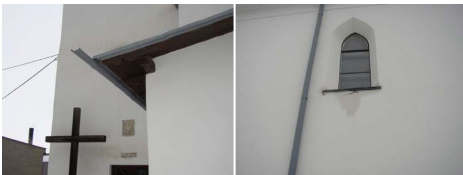
Obr. 11-12: Detail okapu stříšky a detail uložení břidlicové parapetní desky.
