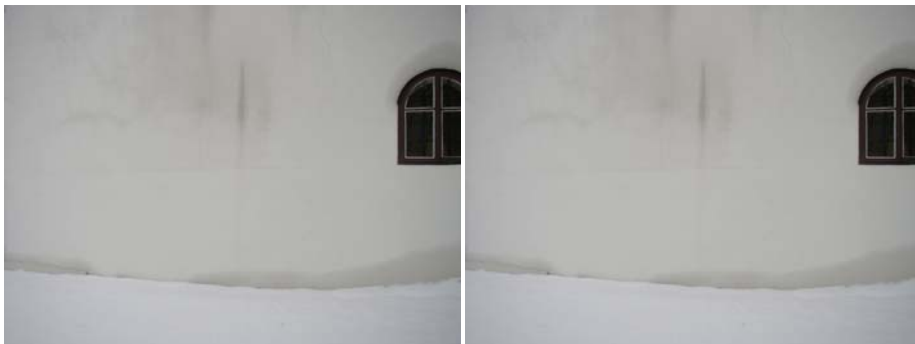
Obr. 13: Nerovnoměrnost vápenného nátěru fasády kostela.
