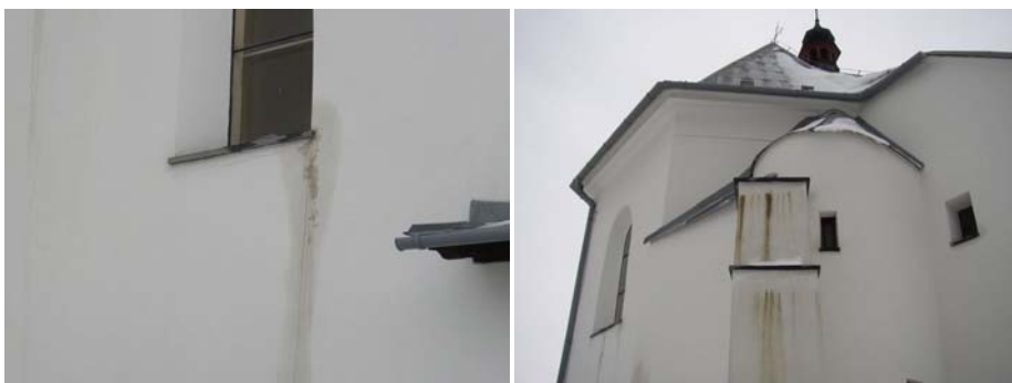
Obr. 14-15: Detail uložení břidlicové parapetní desky a znehodnocení omítek na šikmých stranách opěrných zdí.
