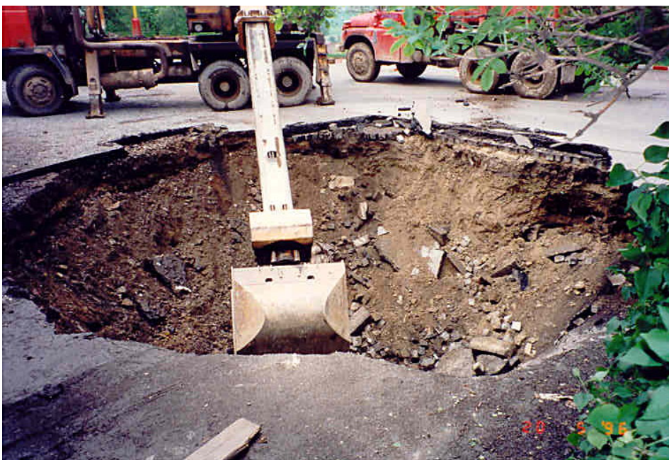
Foto 2 Sanace propadu silnice I/18 v Příbrami – Březových Horách
