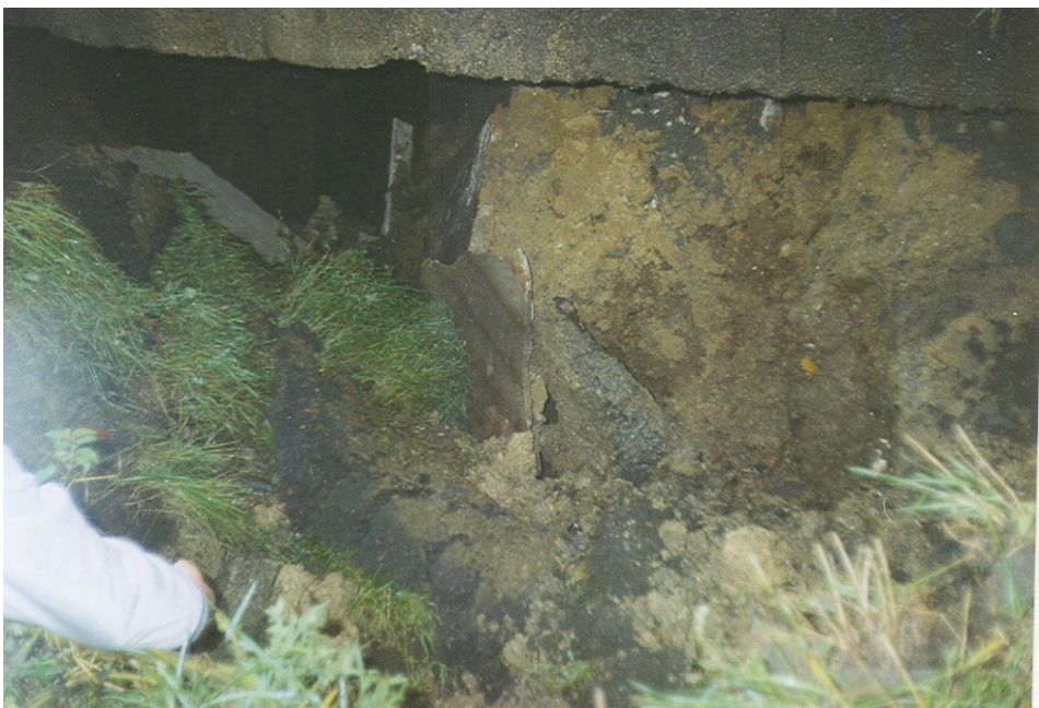
Foto 1 Propad pod silnicí I/5 (E 50) Stříbro
