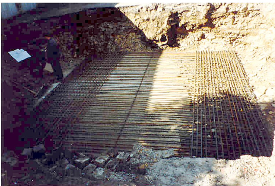
Foto 4 Sanace propadu silnice I./18 v Příbrami – Březových Horách
