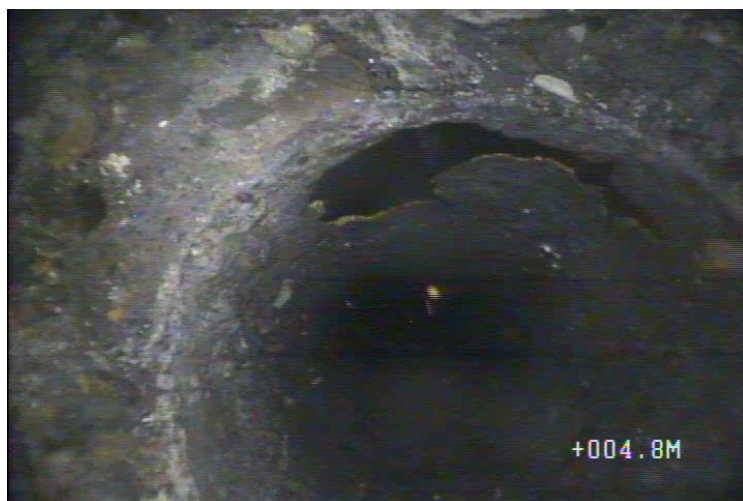
Obr.2 televizní prohlídka starého vrtu před rekonstrukcí- havarijný stav pažnice
