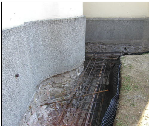
Obr.1: Dodatečné vyztužení základů
