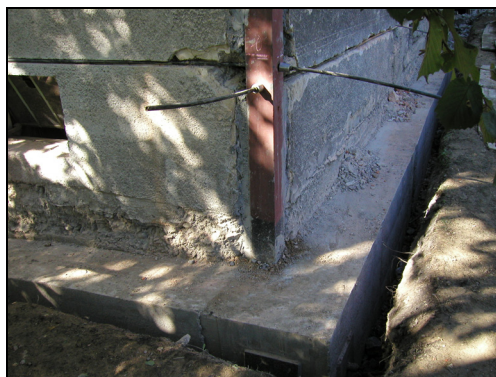
Obr.2: Sepnutí objektu na poddolovaném území předpjatými lany
