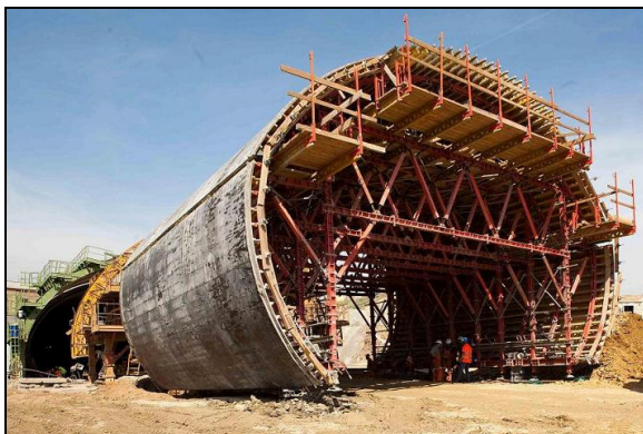
Obr.1: Bednicí forma PERI tunelu (foto PERI s.r.o. ©)
