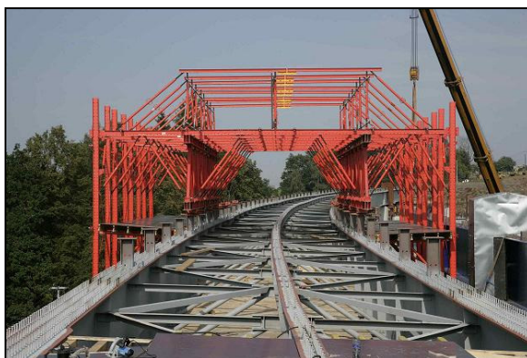
Obr.2: Bednicí forma PERI sprážené mostní konstrukce (foto PERI s.r.o. ©).
