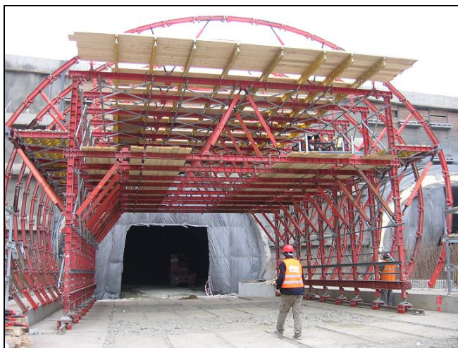
Obr.8: Osazení GRV bran do bednicí formy PERI (foto PERI s.r.o. ©).
