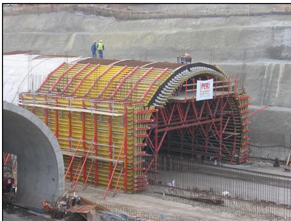
Obr.5: Bednicí forma pro hloubené tunely (foto PERI s.r.o. ©).
