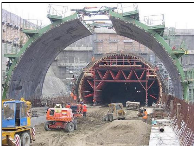
Obr.10: Ocelové vnější bednění – záklop (foto PERI s.r.o. ©).
