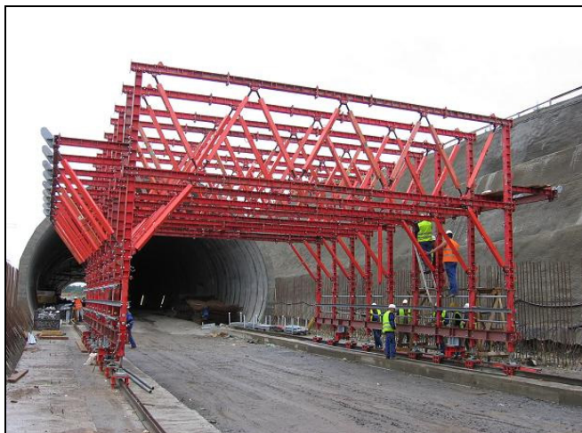
Obr.7: Nosná příhradovina bednicí formy PERI (foto PERI s.r.o. ©).
