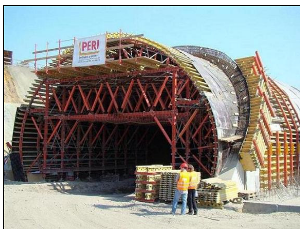
Obr.14: Bednění límce portálu tunelu (foto PERI s.r.o. ©).
