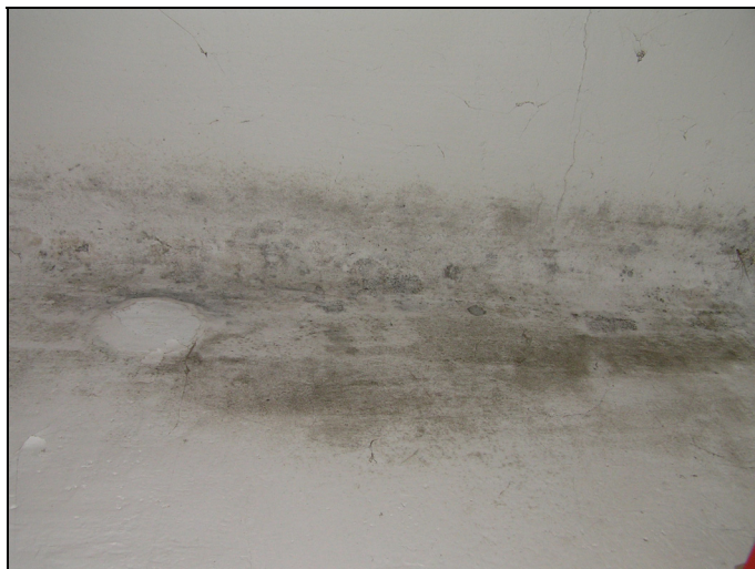
Obr.7: Důsledek kondenzace vodní páry na vnitřním povrchu obvodových konstrukcí – růst plísní
