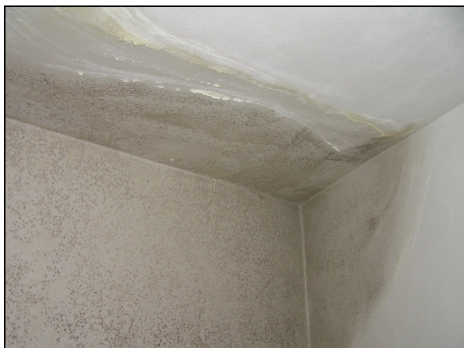
Obr.6: Kondenzace vodní páry v místě obvodové stěny ze železobetonu
