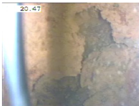
Obr. 1 Poškozená pažnice v důsledku velmi pokročilé koroze
